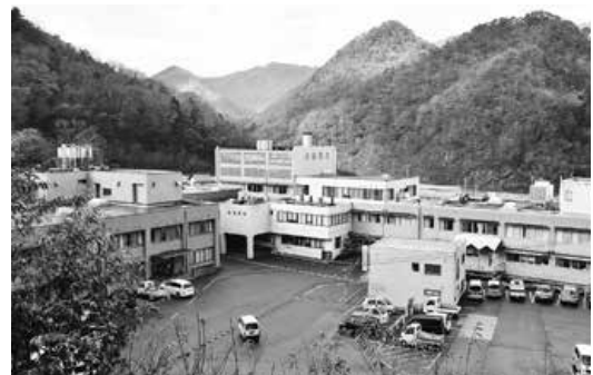
過疎と高齢化の町を支え続ける日南病院
