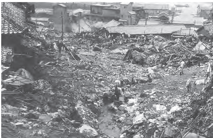
門司風師山の土石流 昭和28年 132名死亡 損壊家屋 2,098棟
